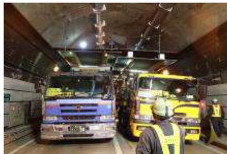
写真-3 トレーラを使用した撤去状況
