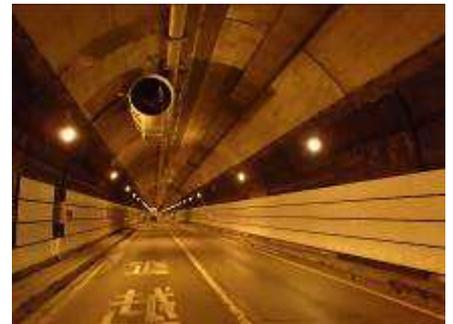
写真-1 天井板撤去完了
