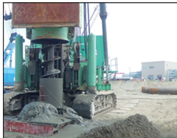
図-3 排熱回収ボイラー基礎杭施工状況
