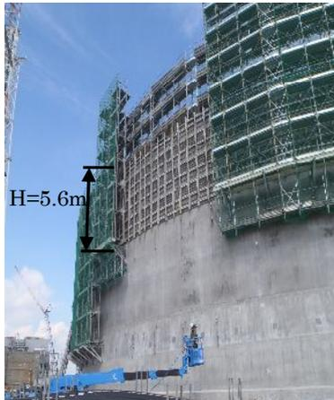
写真-3 LNG防液堤スライド型枠
