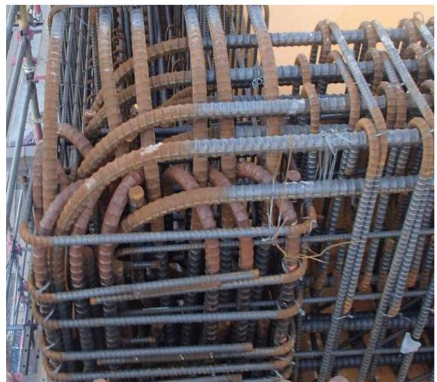
図-2 接合部における鉄筋輻輳状況
