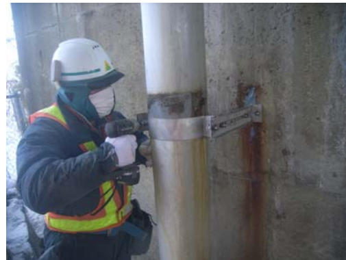
【写真-4 取付金具と施工状況】
