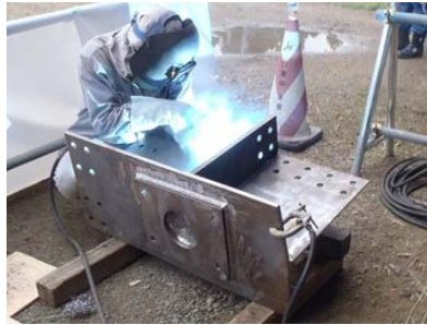
写真－8 垂直補剛材の溶接
