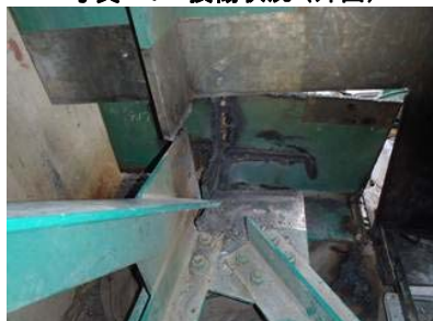
写真-4 部材撤去状況
