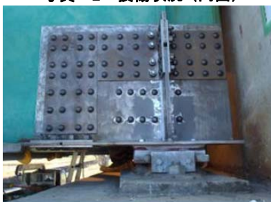
写真-5 部材交換後（外面）
