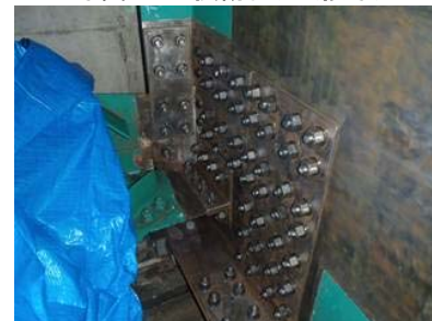
写真-6 部材交換後（内面）
