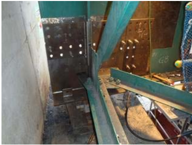
写真－7 垂直補剛材の位置決め
