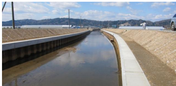
図－2 施工位置状況
