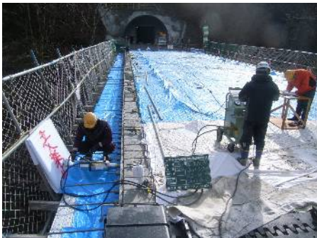
写真－1 PC 鋼材横締め緊張状況
