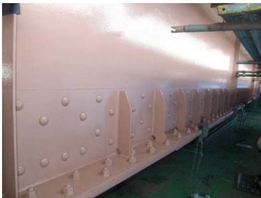
写真-6 鋼桁補強状況
