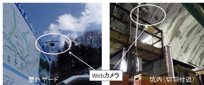
図－３ Web カメラの設置状況
