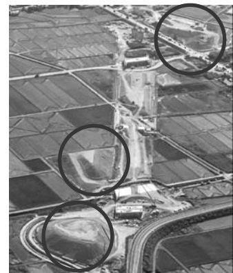
写真-3 盛土材の仮置き状況
