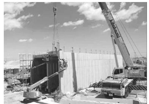
写真-2 ボックスカルバート二次製品化
