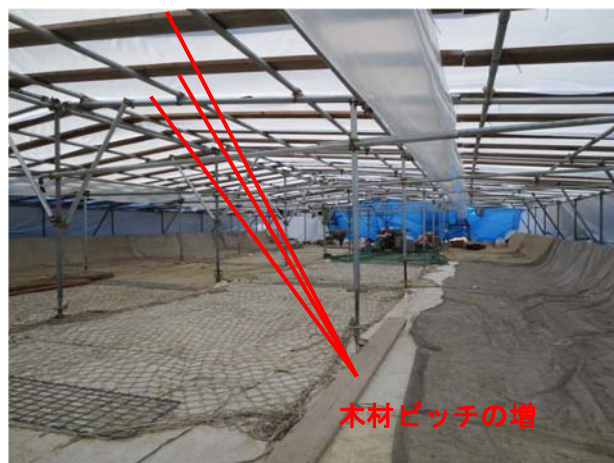
写真－３. 屋根改良状況
