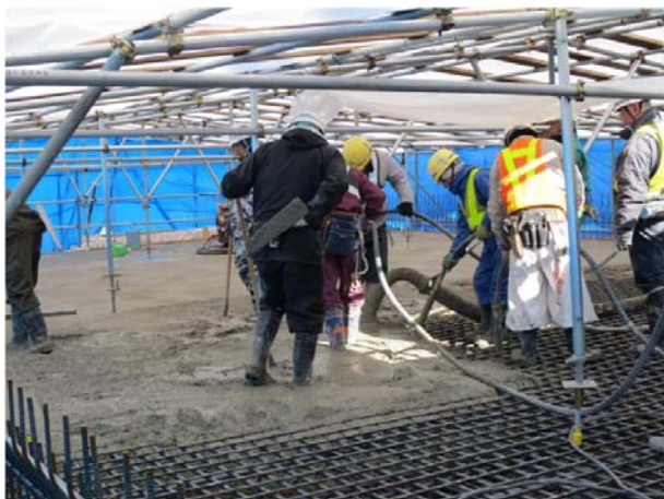
写真－１. コンクリート打設状況
