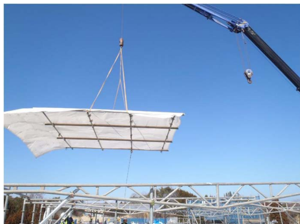
写真－２. 屋根設置状況(施工方法①)
