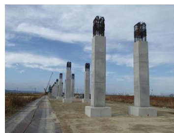
図-7 施工後の状況
