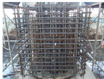
図-5 根巻き鉄筋組立状況
