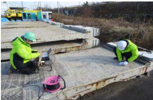
写真-1 撤去床版測定状況
