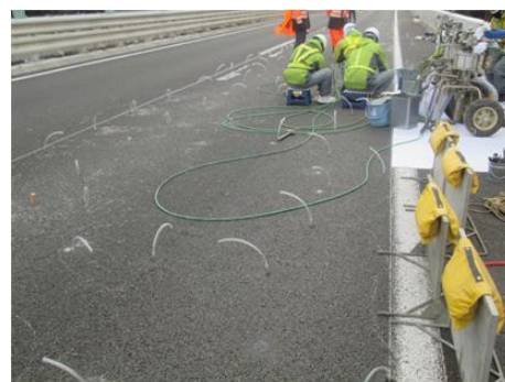
写真-1 注入作業状況
