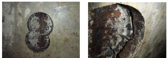
写真-1 内部鉄筋腐食状況
