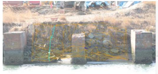
図-8 レンガ橋台(下の橋)の写真撮影とパソコン上での測点入力(Photog-CAD)
