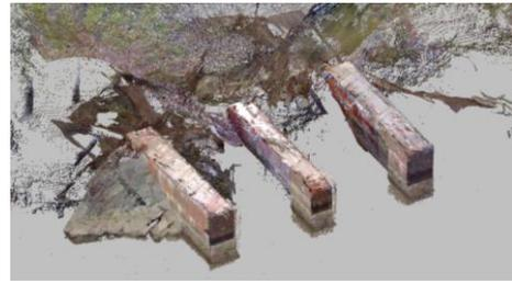
図-6 レンガ橋台(下の橋)の津波被災状況
