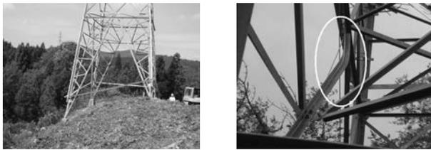
図-1 地盤変状による脚部不同変位(左手前の脚) 図-2 脚部不同変位による部材損傷事例
