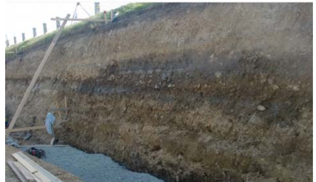
【写真 - 5. 盛土内不透水層】
