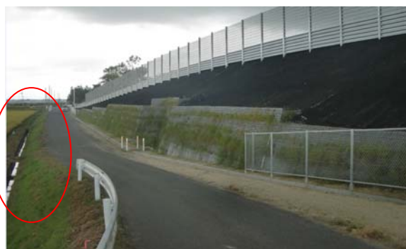
【写真 - 3. 凹型排水路計測】
