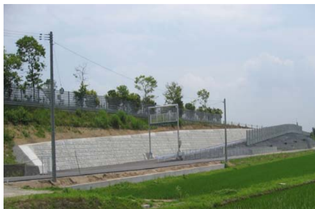
【写真 - 2. 下り線退出路完成状況】
