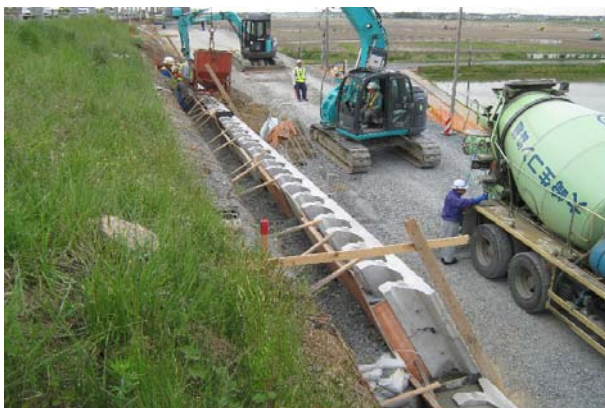
【写真 - 6. 大型ブロック積工】
