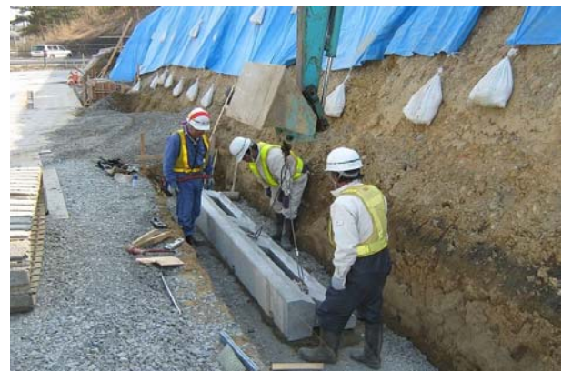
【写真 - 7. プレキャスト基礎工】
