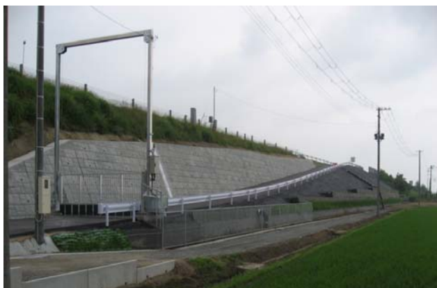
【写真 - 1. 上り線退出路完成状況】
