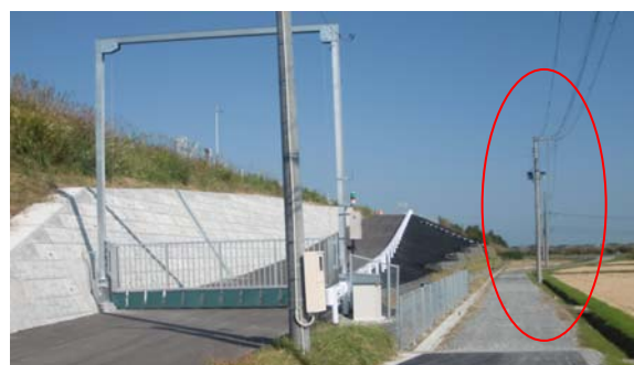
【写真 - 4. 鉛直度計測】
