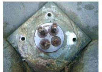
写真3 PC鋼より線引込まれ状況
