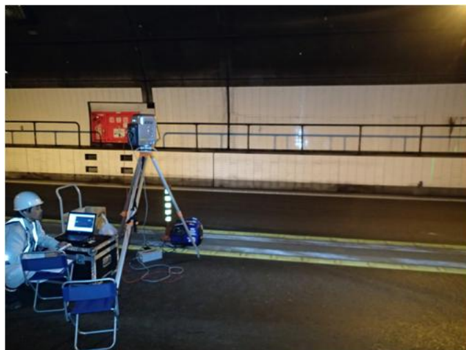
写真-1 3D スキャナー計測状況
