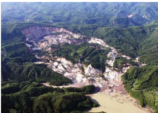
写真-1 荒砥沢ダムの地すべりの状況
