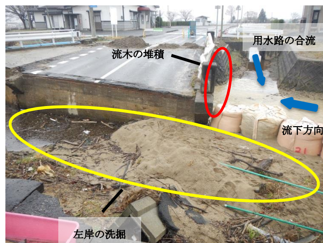
写真1: 岩崎川橋の様子(2013/12/12 左岸より撮影)
