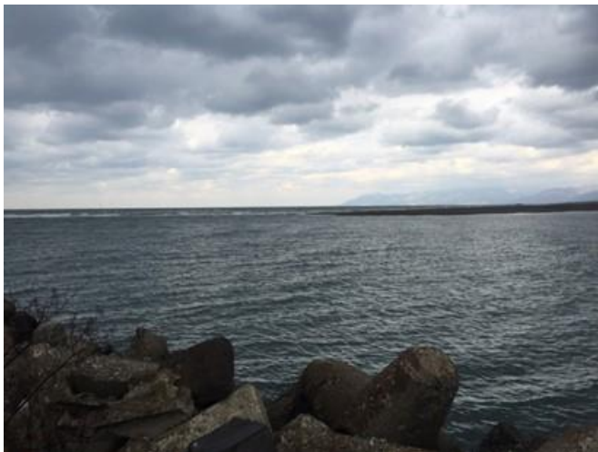
写真-1 河口砂州の様子 (2014年11月19日)
