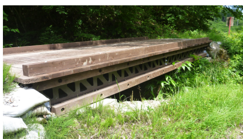
図-1 プレストレス木箱桁橋
