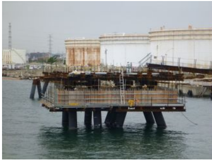
写真-1 足場・型枠設置状況
