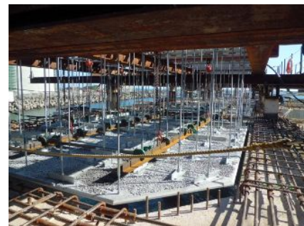
写真-3 埋設型枠架設状況
