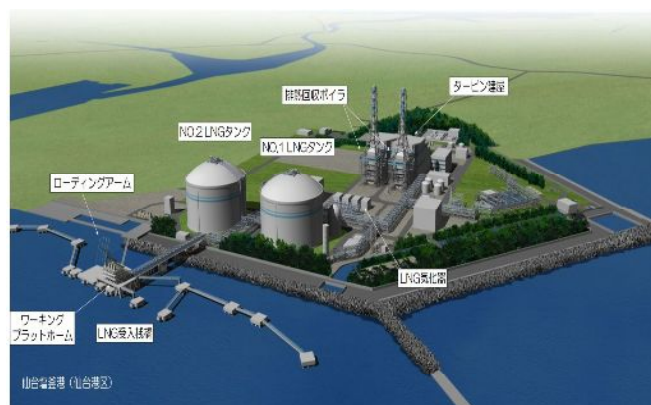
図-1 LNG受入栈橋完成イメージ
