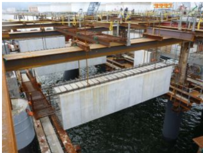
写真-2 プレキャスト梁架設状況
