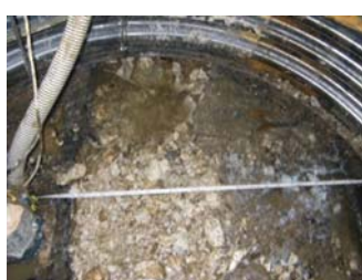
写真-3 Cor 管除去状況
