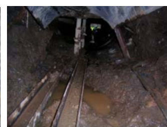
写真-6 防護状況
