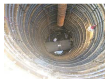
写真-7 新設管路立坑へ到達
