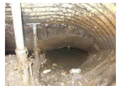
写真－2 Cor 管内部（支保工済）
