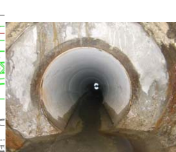
写真-8 完成写真（上流側）
