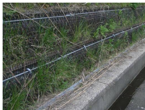
写真－4 留めピン間隔見直し後の状況
