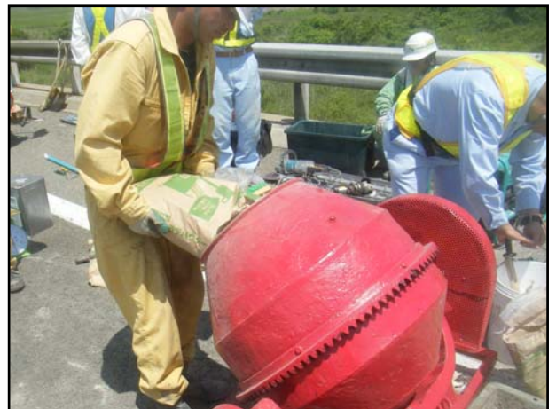
図5. 傾動ミキサによる練混ぜ状況
