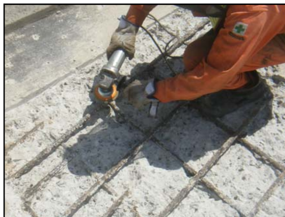
図3. ブラシによる鉄筋の錆落とし作業
