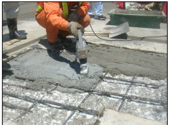
図7. ポリマーセメント系モルタルの締固め作業
