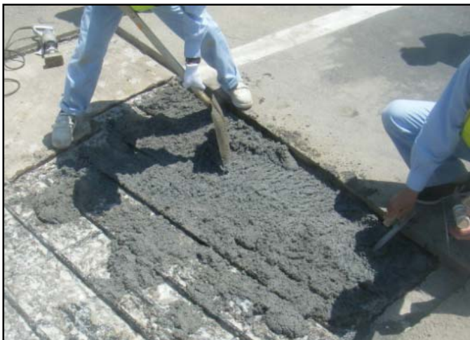
図6. ポリマーセメント系モルタルの敷き均し作業
