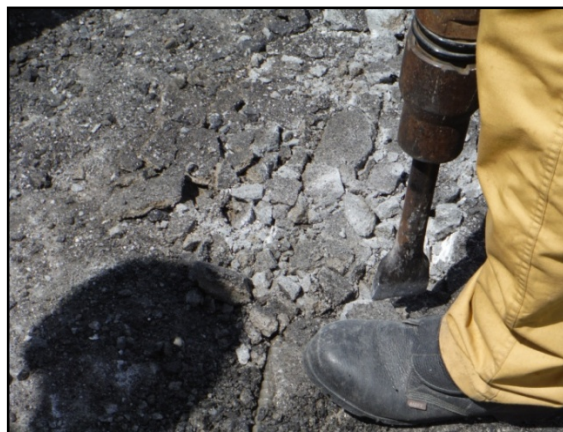
図1. 床版のはつり作業
