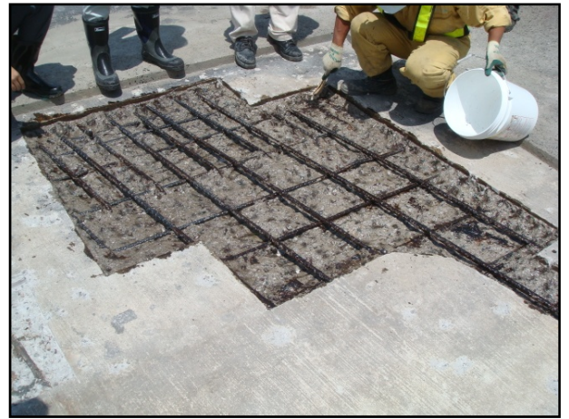
図4. 浸透性接着剤の塗布作業
