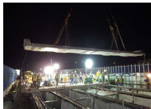
写真-4 新設 PCa 床版の架設
