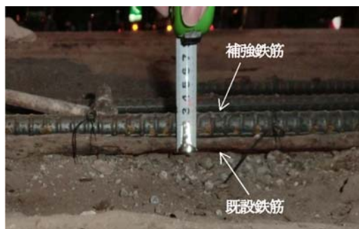
写真－2 断面欠損した既設鉄筋と補強鉄筋
