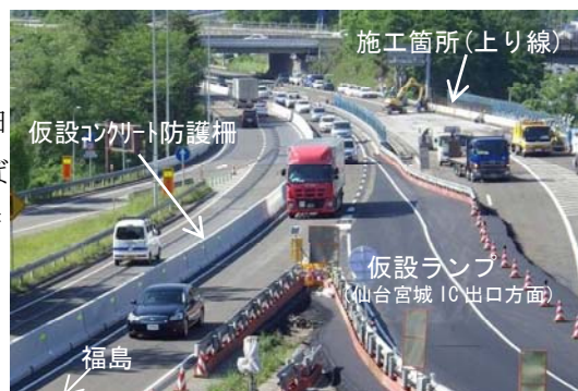
写真-3 対面交通規制の状況
