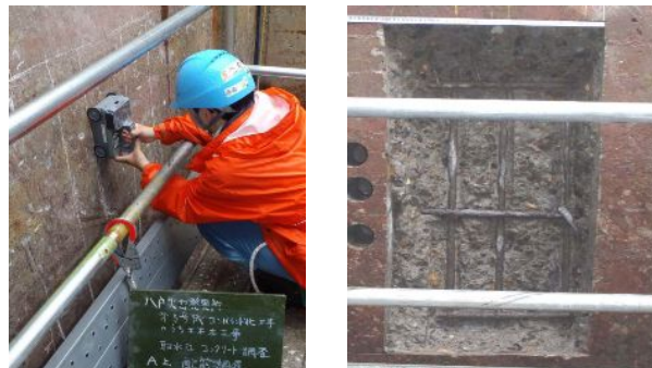
写真-2 鉄筋探査状況 はつり調査状況
