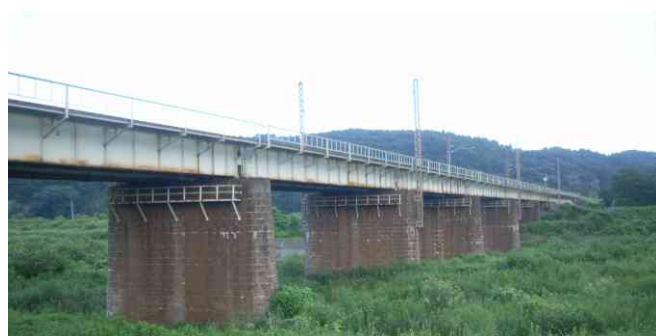
写真-1 橋りょう全景
