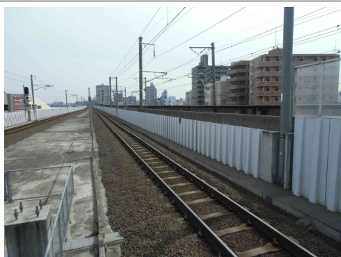
図-1. 防音壁 (FRP 防音壁の例)
