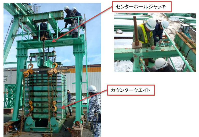
写真-① 主桁吊上げ試験状況
