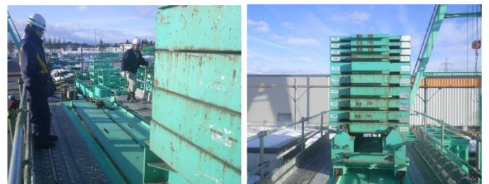
写真-② 主桁縦取試験状況
