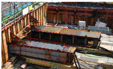
図-6 FCプレート設置
