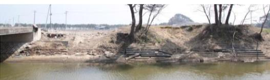
写真-2 松の根周辺の護岸の被災状況
