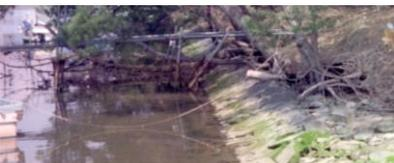
写真-1 船舶の航跡波と護岸の破損
