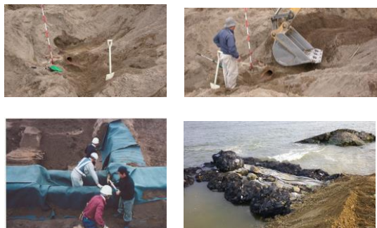
写真-1 悪水吐暗渠の発見と発掘調査後の埋戻し
