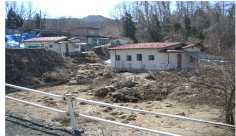
写真 1 崩壊現場の状況
