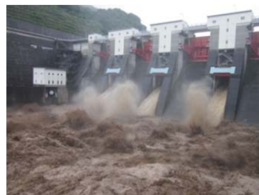
写真-1 御所ダム放流状況
