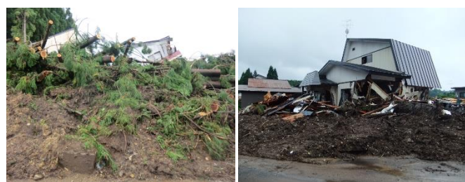
図-4 全壊の家屋、一例× 図-5 半壊の家屋、一例△
