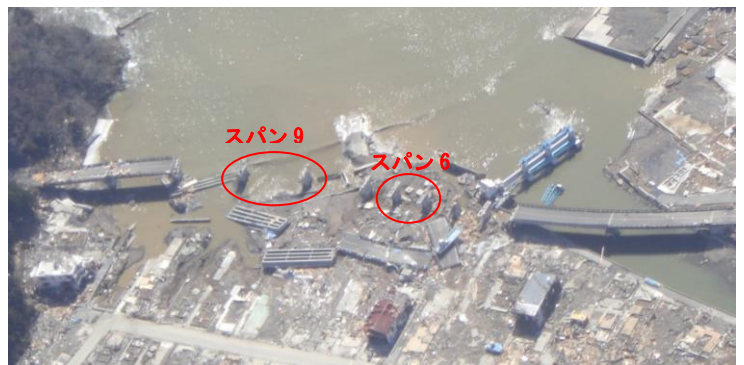
図-1 歌津大橋被災写真(国土交通省から)
