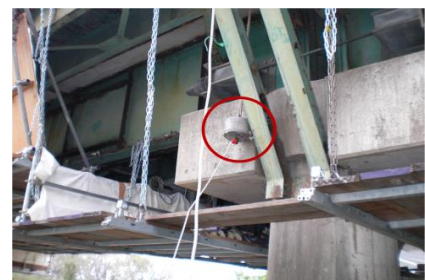
写真-1 P 8 橋脚への重錘設置状況
