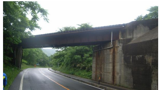
図－1 S 架道橋 全景
