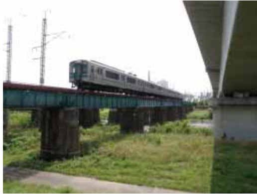
写真-3 フィールド試験現場全景
