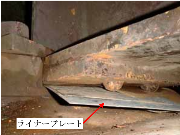
写真-1 ライナープレート挿入状況
