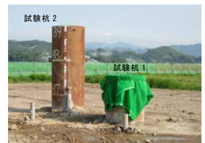
写真－2 打設後の試験杭の状況
