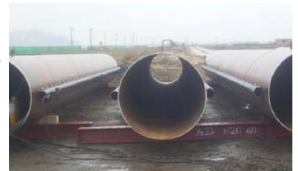
写真－1 炭素鋼鋼管を溶接した試験杭
