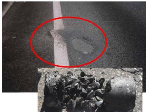
図-1 浸透水によりはく離・土砂化した基層
