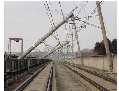
写真-1 震災後の新幹線電化柱
