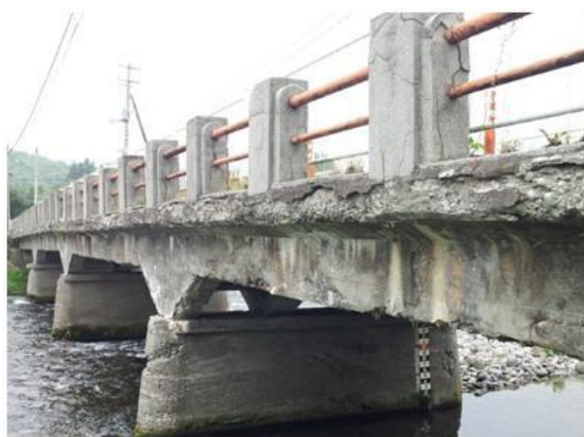
写真-1 法量橋側面（上流側）
