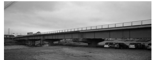
写真-1 対象橋梁全景
