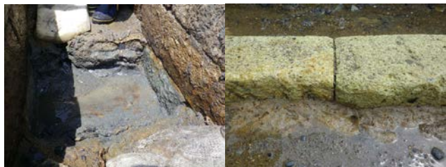
写真-3 津波後に発見の悪水吐暗渠跡
